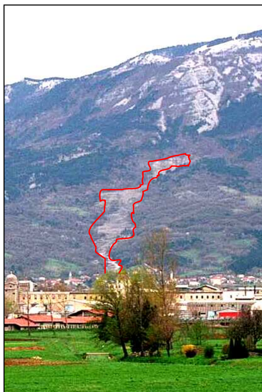
Fig. 5 The Slano blato landslide
