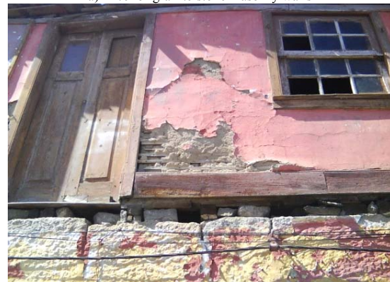
b) Exterior tabique walls
