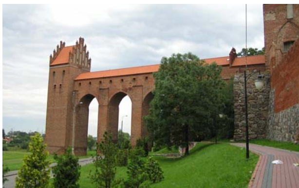
Fig. 7. Kwidzyna. The “toilet” tower (photo: R. Gubańska)
